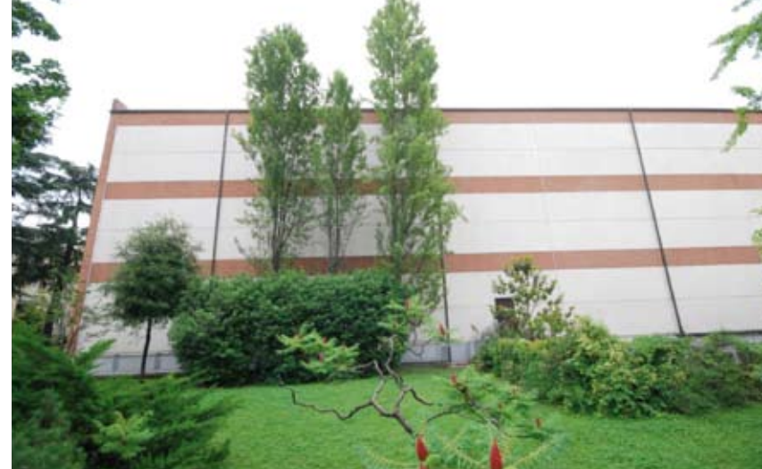
In alto: la facciata Ovest del magazzino, che ora funge da centro logistico per i beni sanitari ed economici. In basso: porzione del piano terra del magazzino dopo la realizzazione dell'impresa appaltatrice
